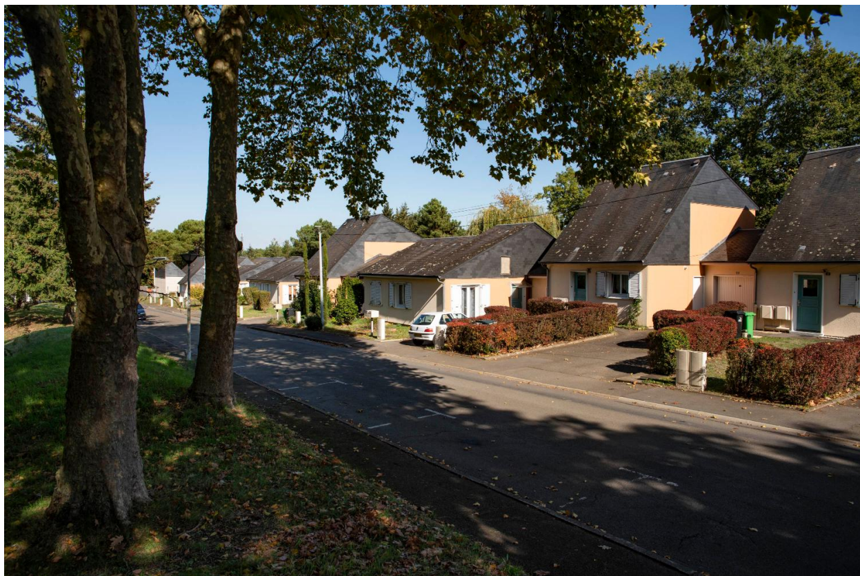
Vue de l'alignement des maisons cour des frênes.
