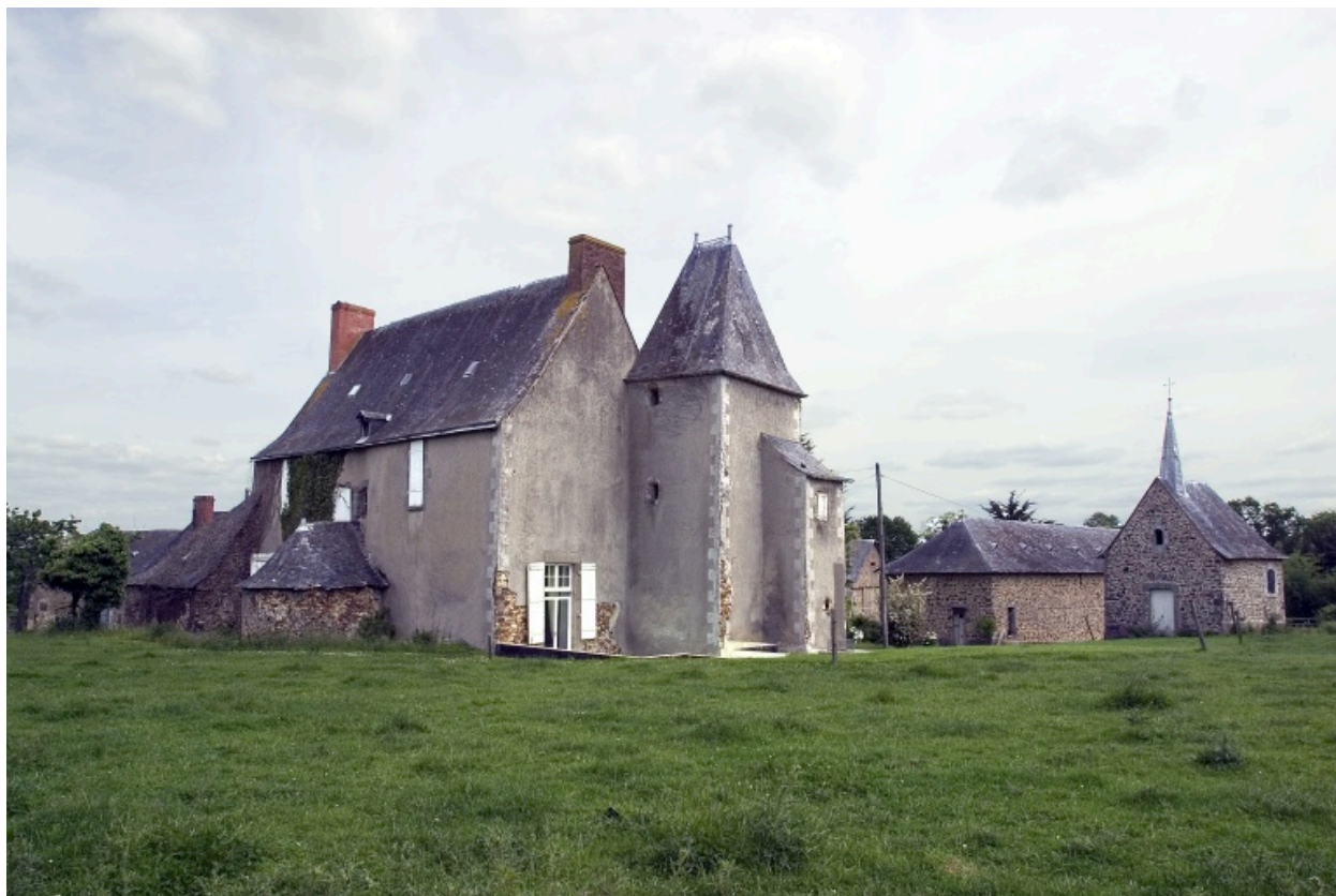
Les élévations ouest et sud du logis.
