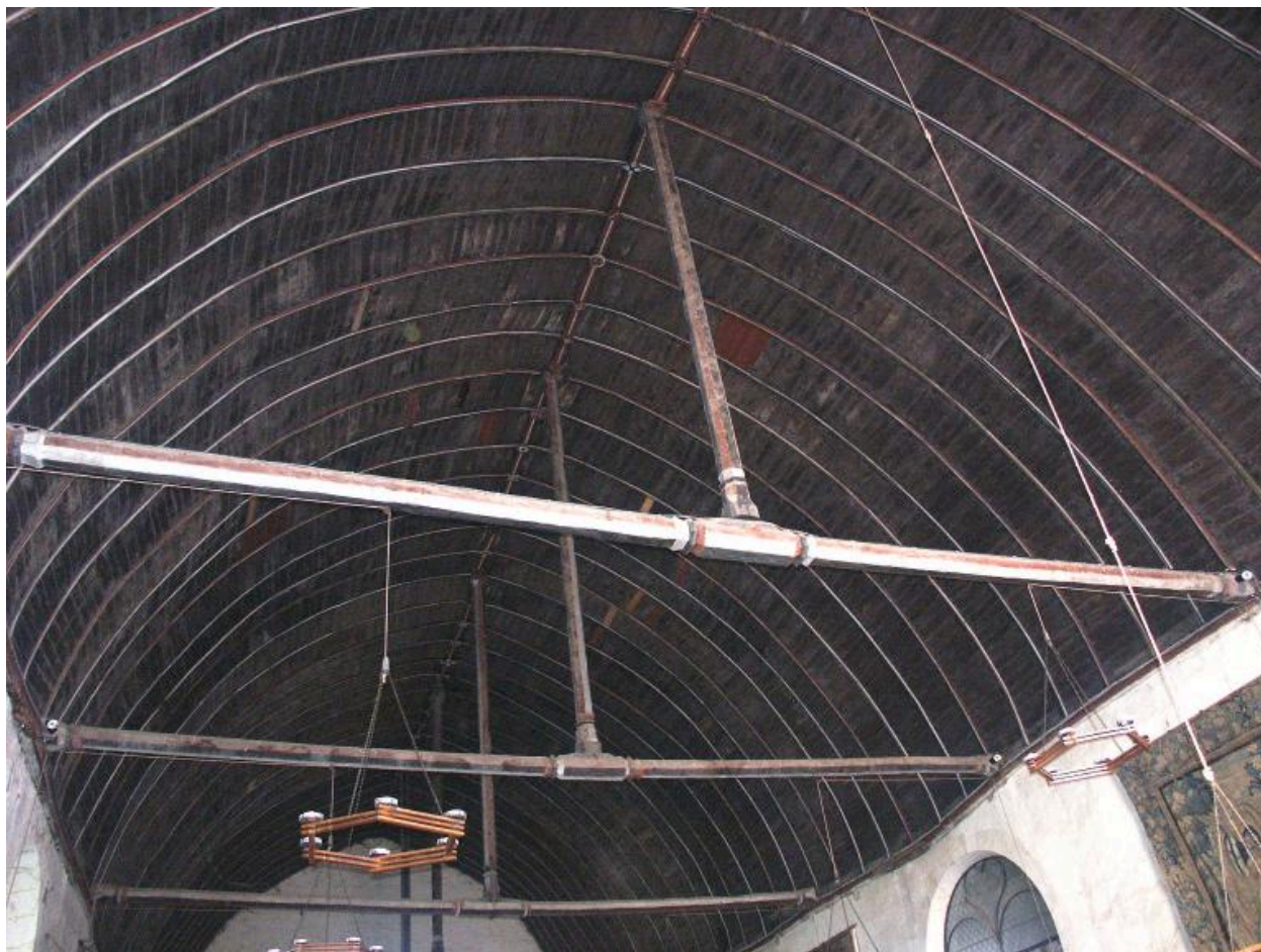
Vue d'ensemble du lambris avant destruction.
