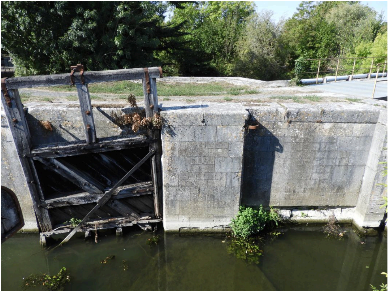
Porte à flot, à gauche, et emplacement de la porte d'èbe, à droite, à la tête amont de l'écluse, rive droite.
