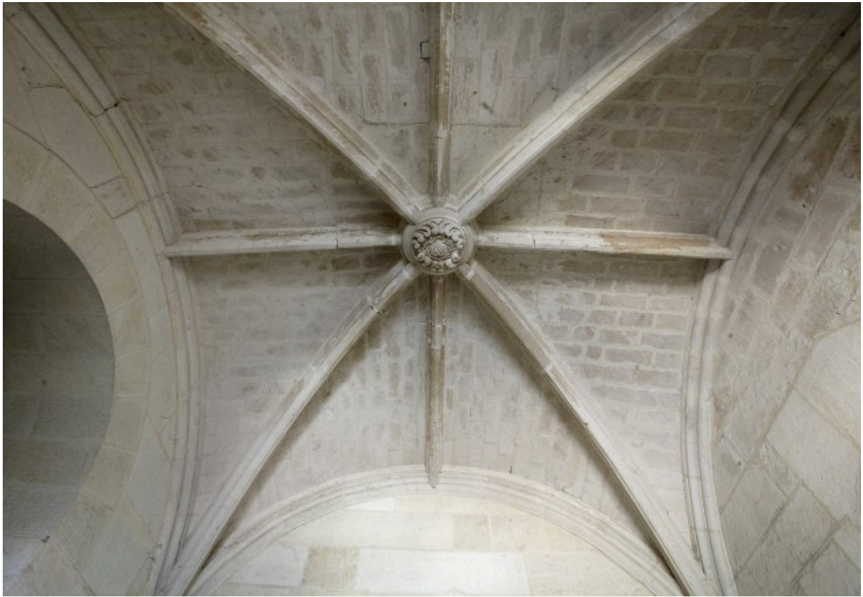
Premier étage du massif occidental : voûte de la travée sud.
