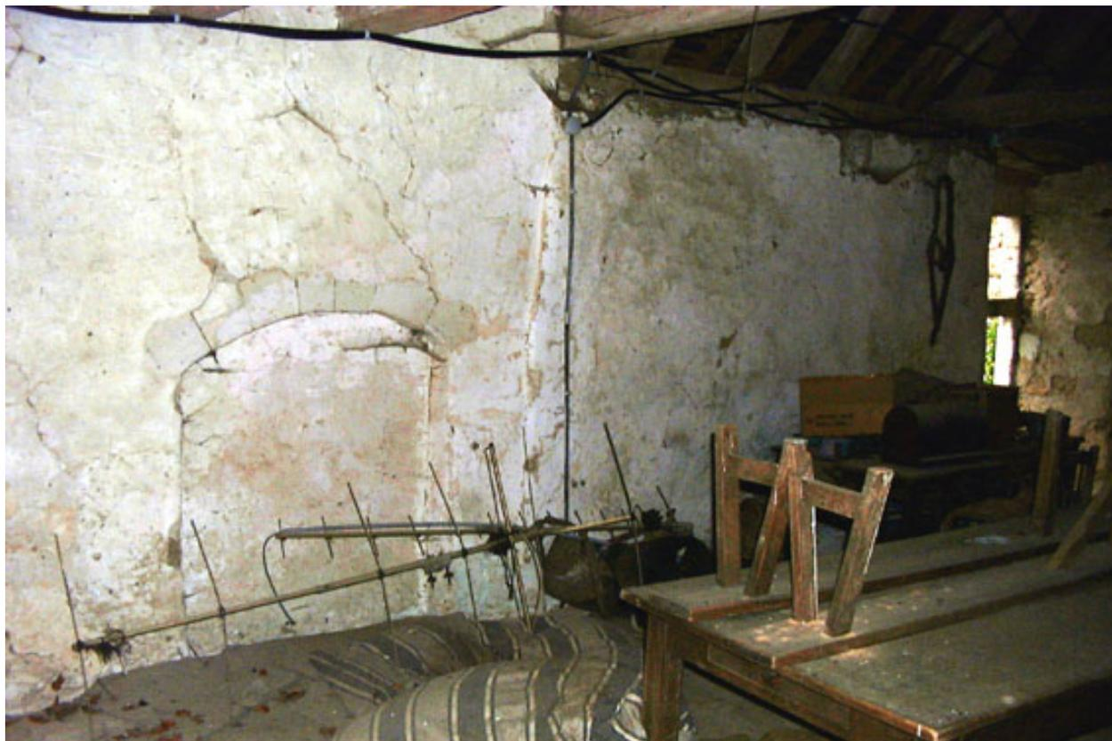
Parement intérieur du mur gouttereau sud de la partie orientale du logis. On aperçoit les vestiges d'une ancienne ouverture murée (porte originelle ?). A droite, l'appui de la croisée est placée au niveau du sol, ce dernier ayant été surélevé à une époque tardive.
