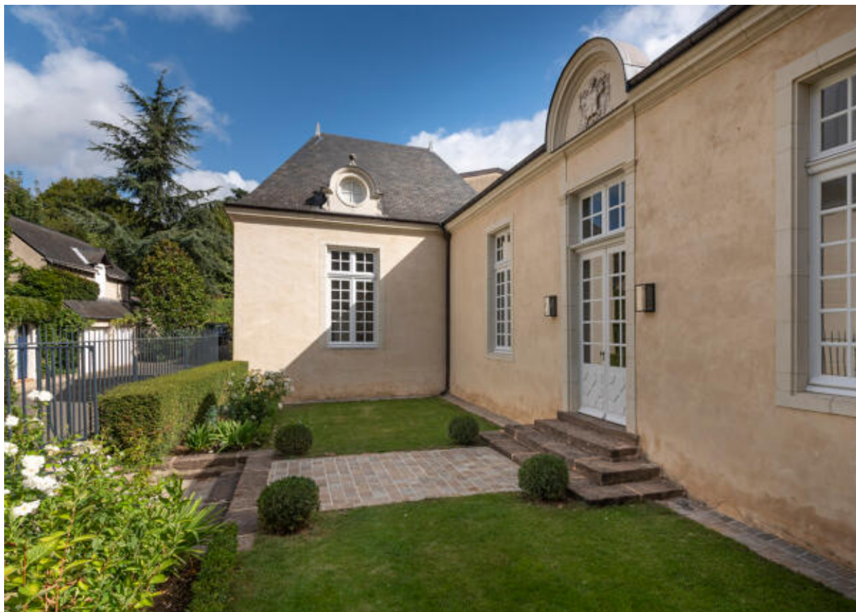
Vue de la façade principale et de l'aile en retour nord de Maupertuis.
