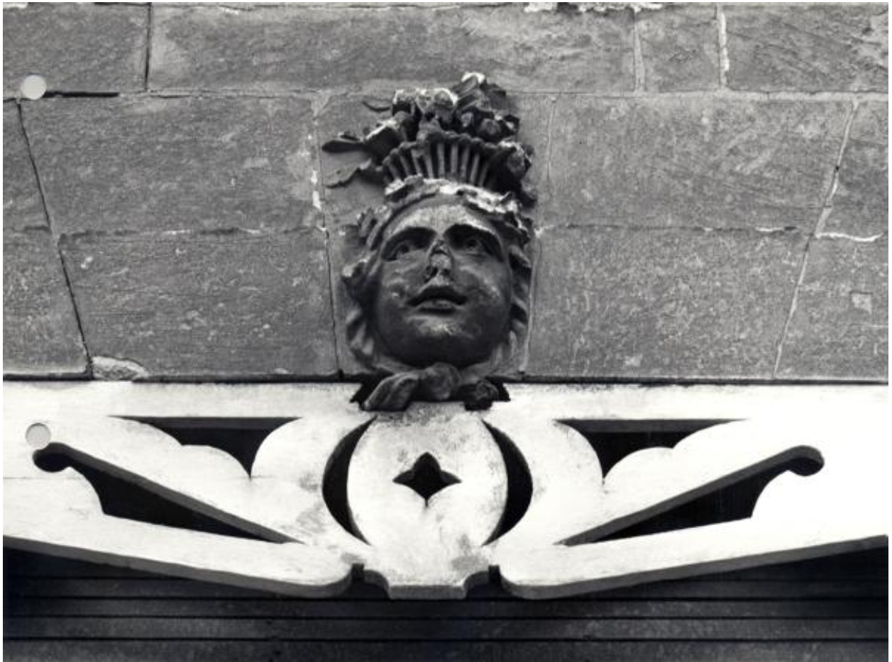
Elévation sur la rue Boisnet : 1er étage, mascarón de la travée centrale droite.
