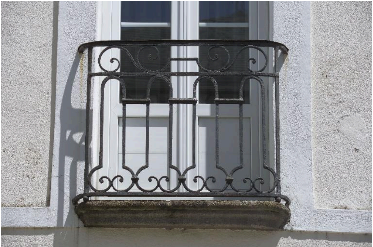
La façade sur la rue, détail d'un balconnet.
