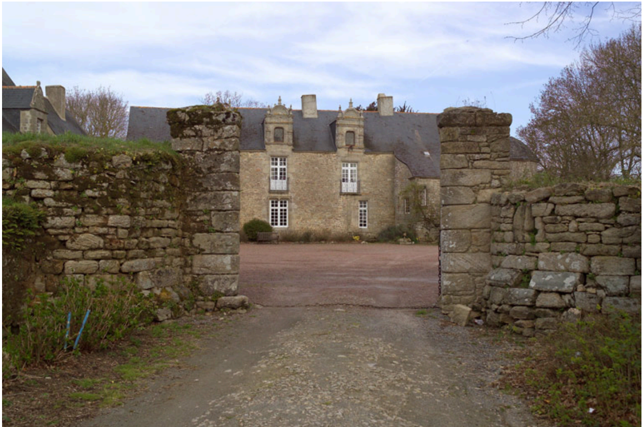
Élévation antérieure du logis depuis le portail.
