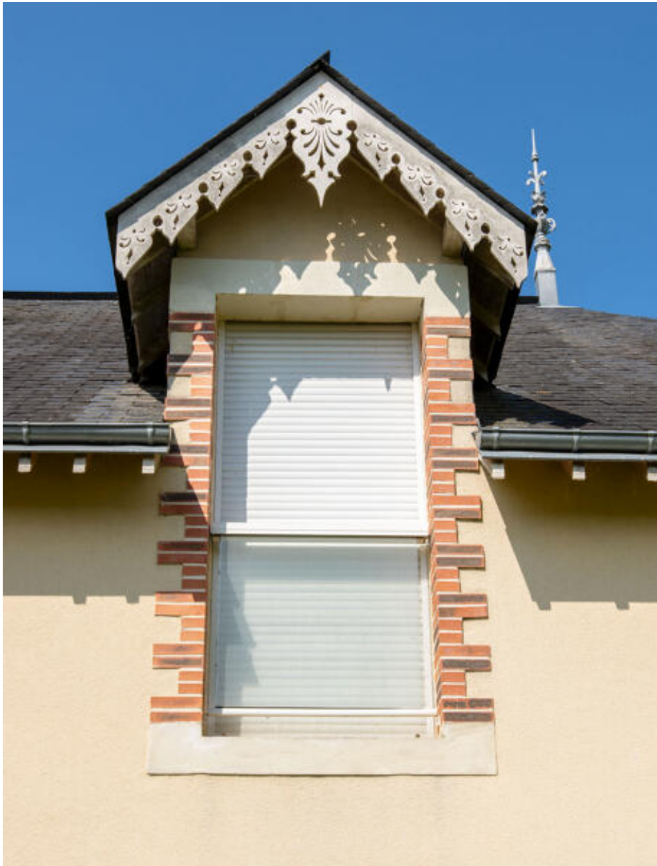
Un détail d'une lucarne passante.
