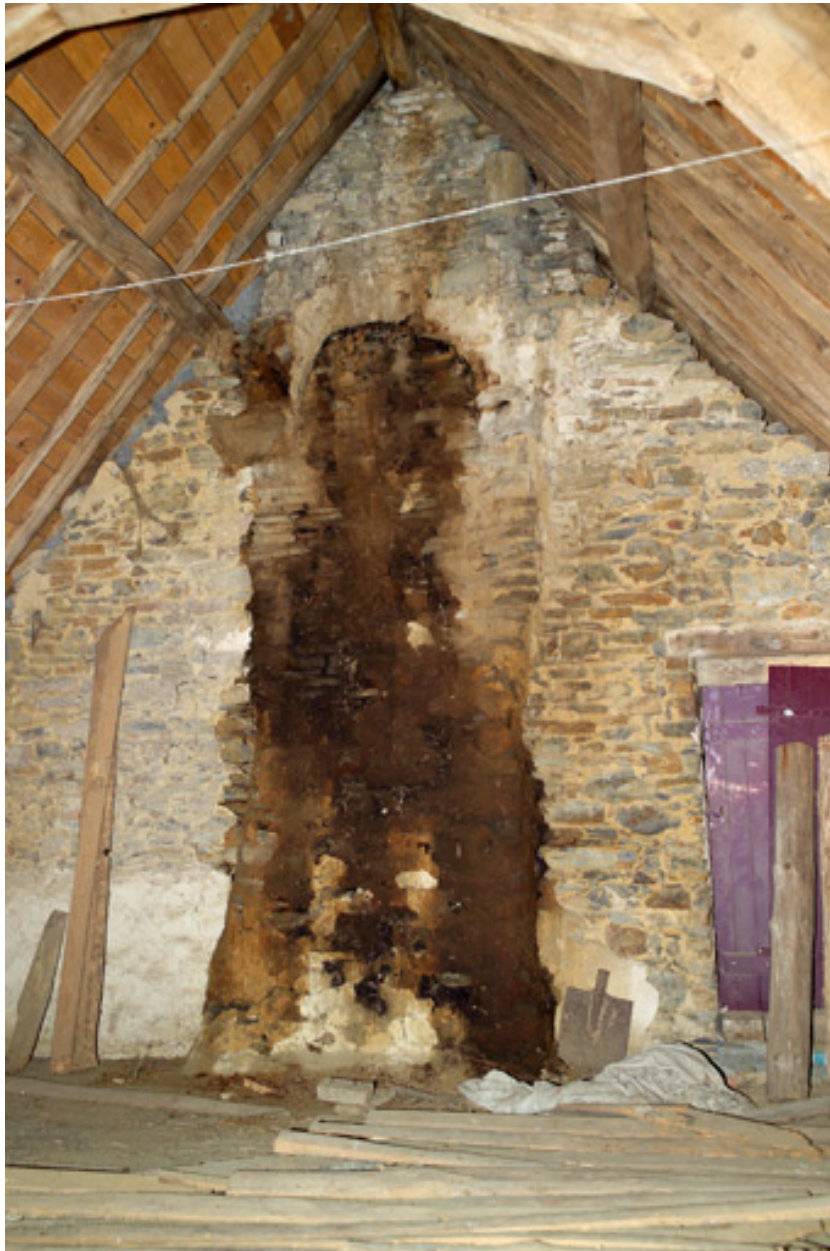
Conduit de cheminée dans le comble de l'avant-dernier logement à l'est.
