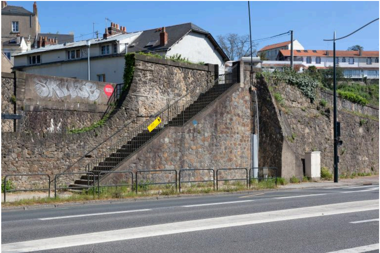
Ancien franchissement de la voie ferrée du boulevard de Cardiff vers la rue Joseph Cholet.
