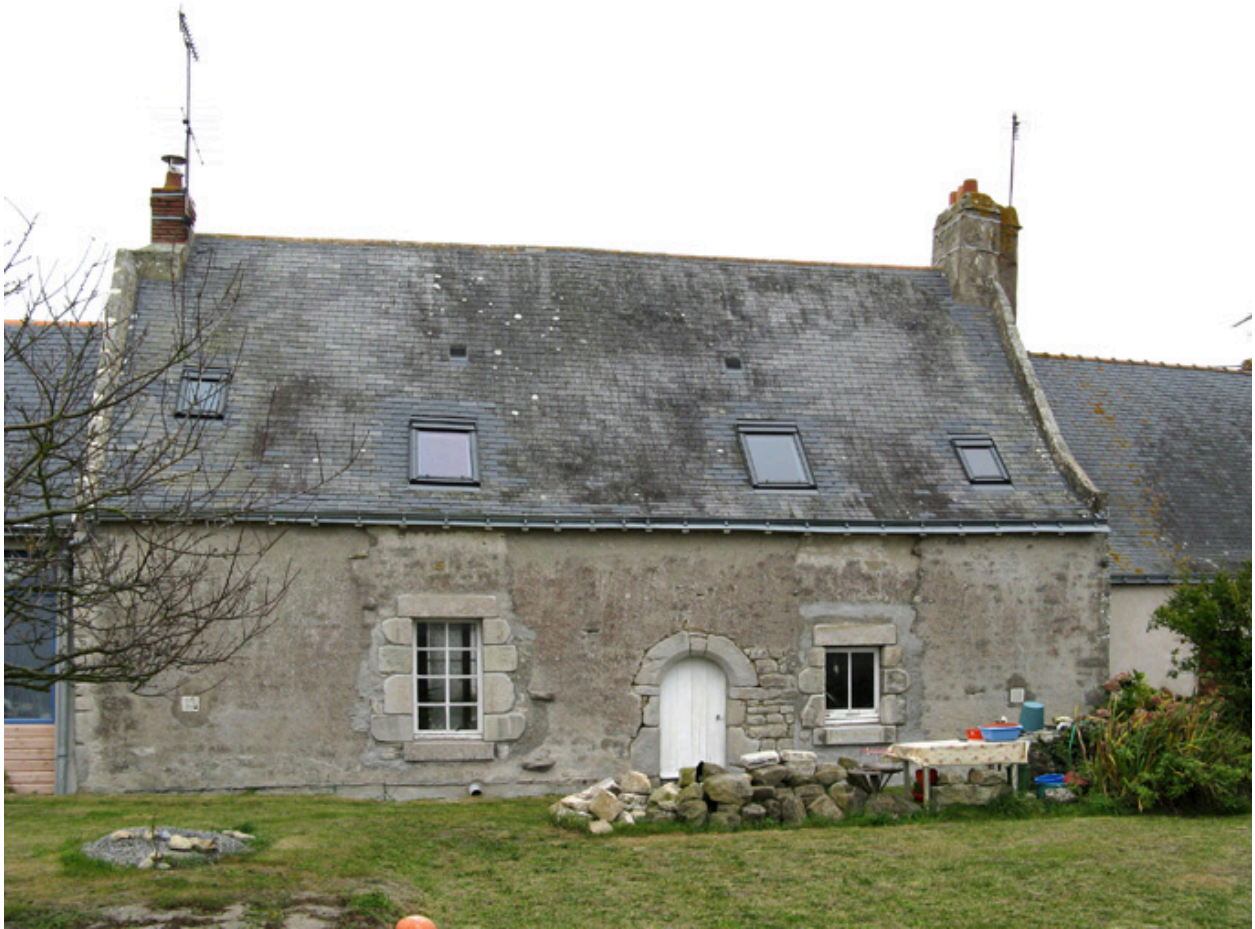
1er logis. Façade ouest.
