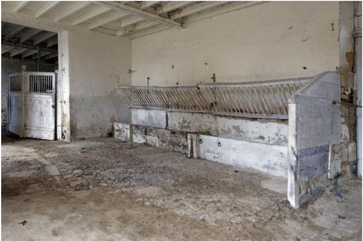
L'aile de communs nord, intérieur de l'écurie.
