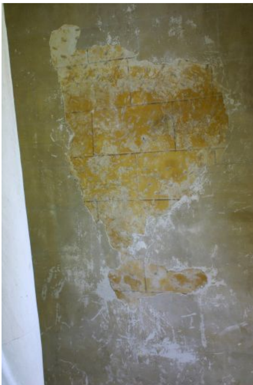
Escalier en vis, détail : enduits superposés.
