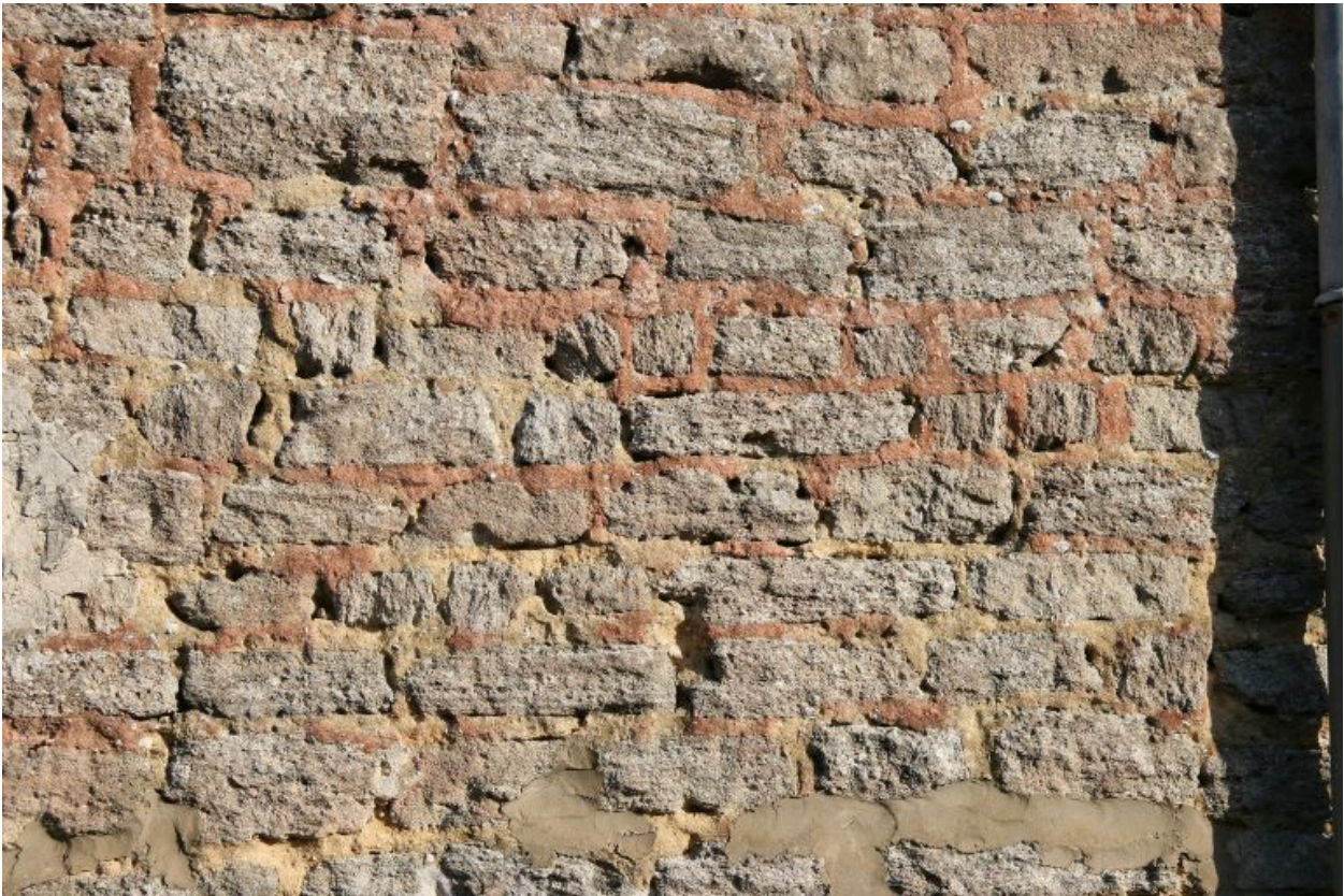
Mur sud de la nef : détail des enduits et joints.
