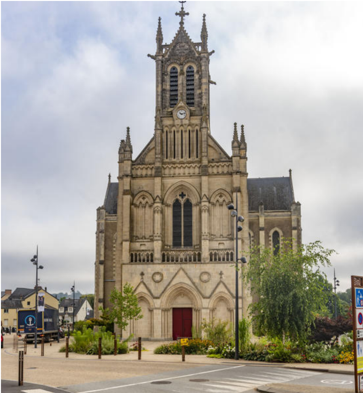
La façade occidentale.
