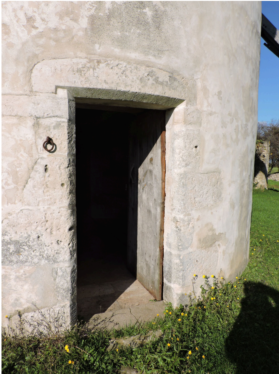
Porte à encadrement chanfreiné au sud-est du moulin.
