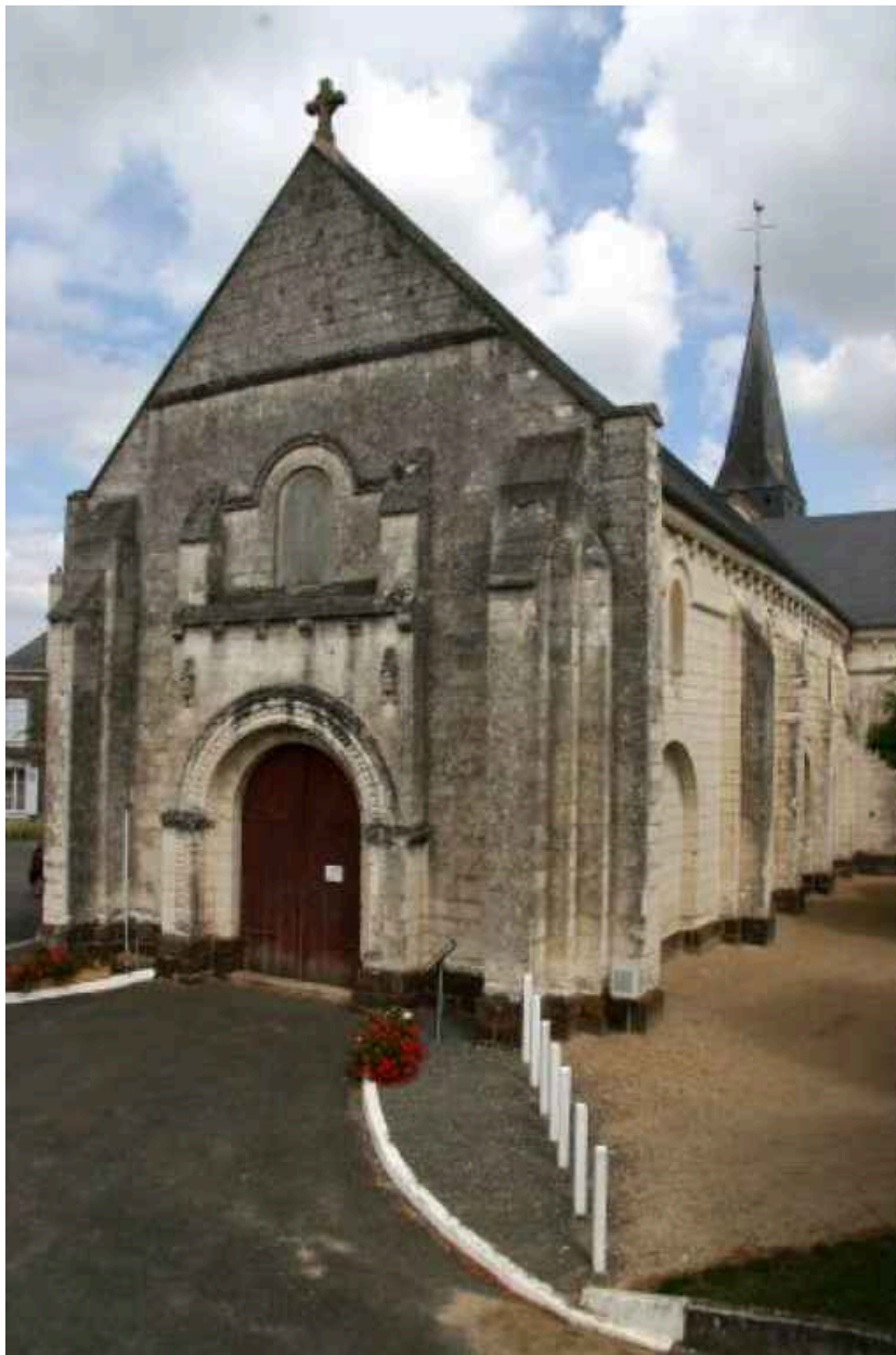
Façade occidentale remontée au XIXe siècle.
