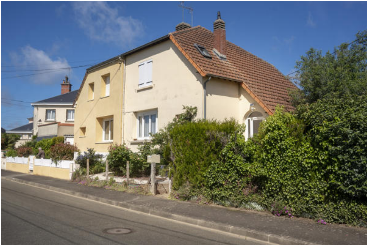
Vue de pavillons jumeaux pour ouvriers.
