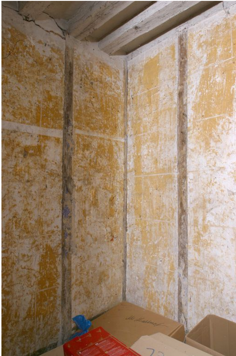
Etage de comble, pièce nord : les murs du garde-robe avec leur faux appareil.
