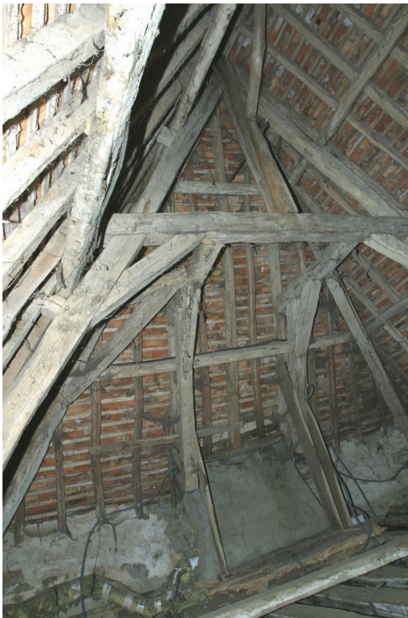
La charpente de la partie ouest du logis vue depuis l'est.
