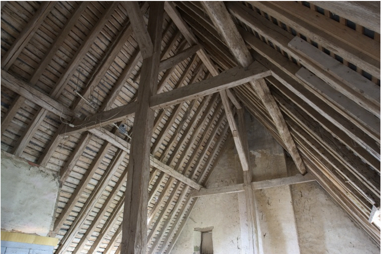
Comble du logis : la charpente.
