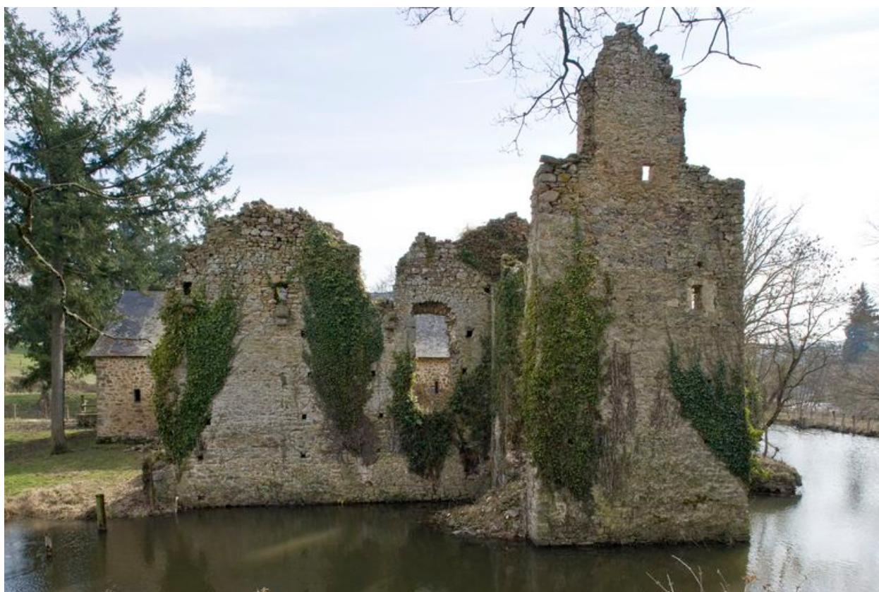
La maison-forte : vue d'ensemble depuis le nord-ouest.
