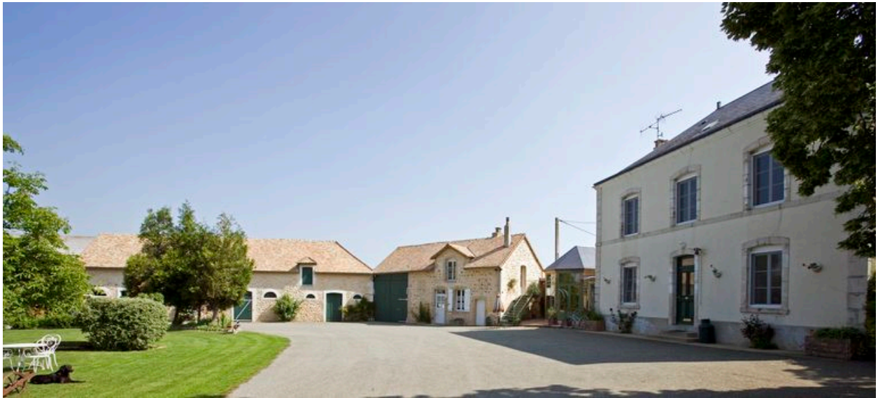
La Renoncière : vue d'ensemble depuis le sud.
