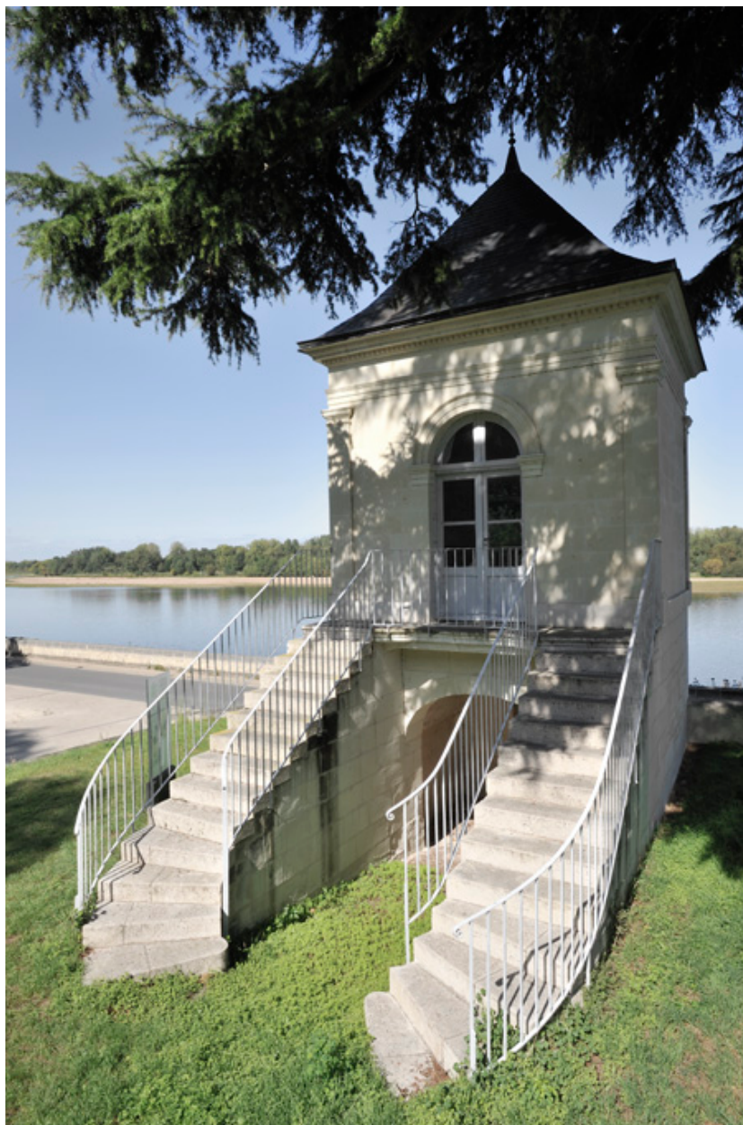
Pavillon : vue générale depuis le parc.
