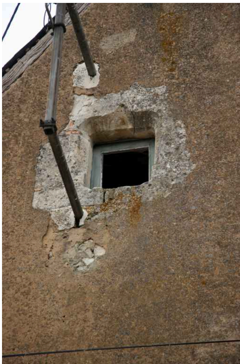
Baie chanfreinée du comble.
