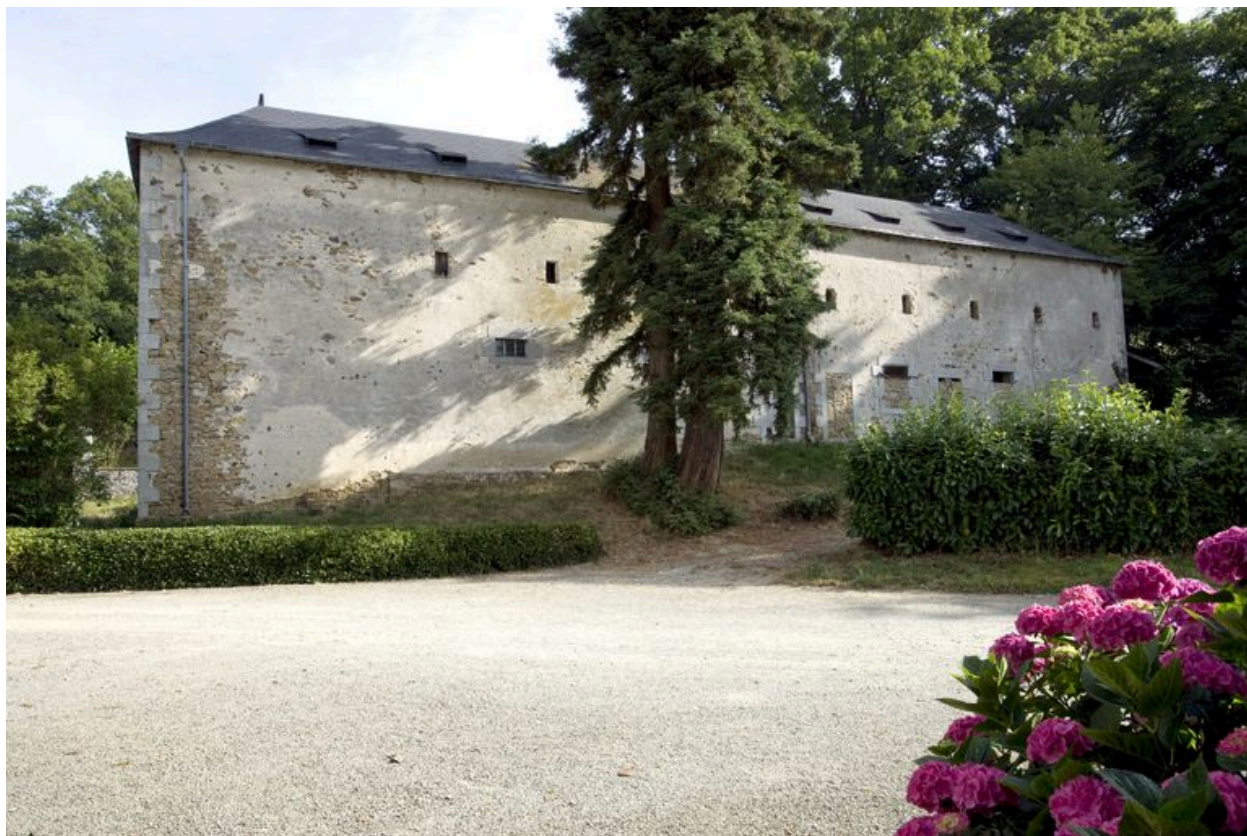
Ecurie-grange : façade postérieure vue depuis le sud.
