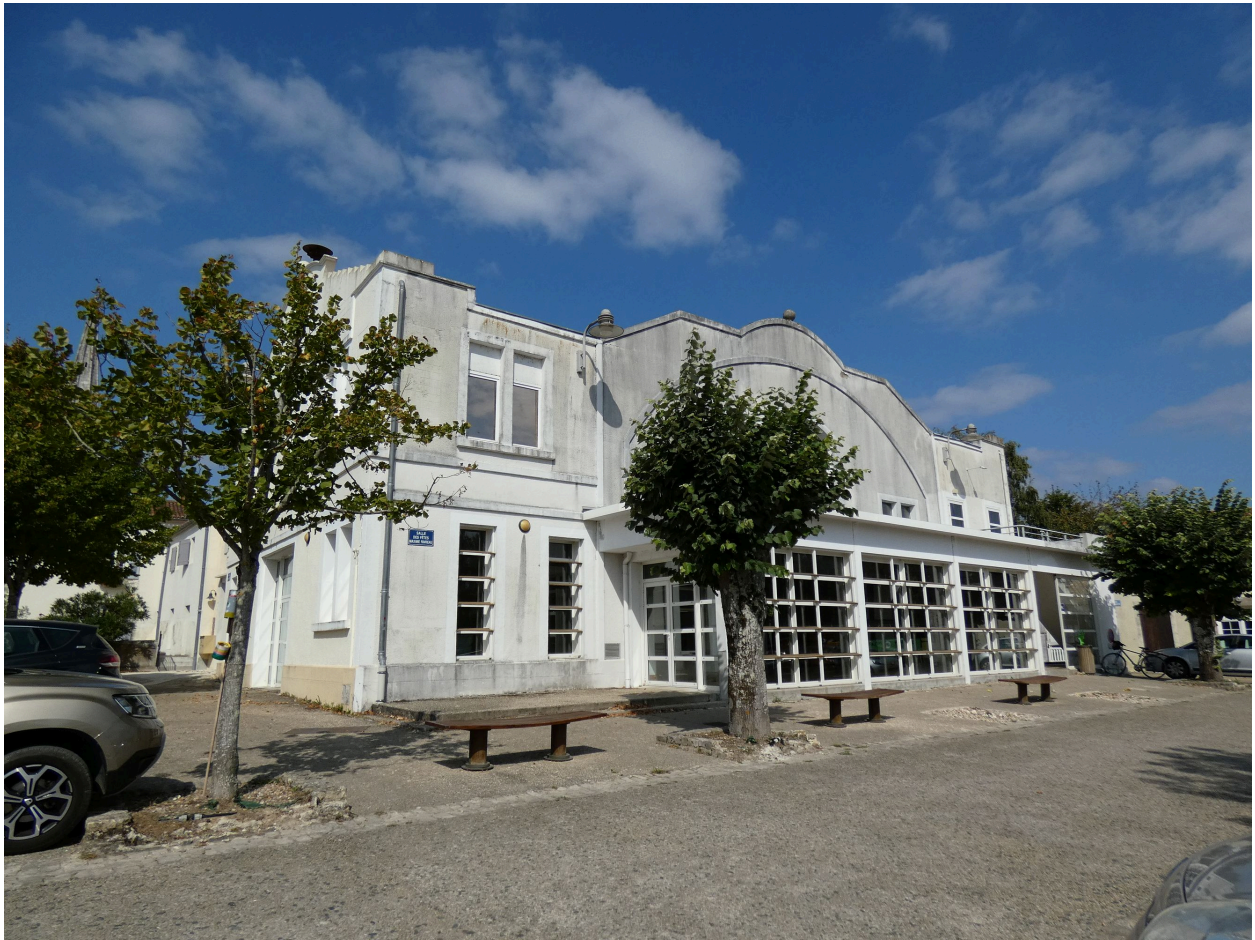
La salle vue depuis le sud-ouest.
