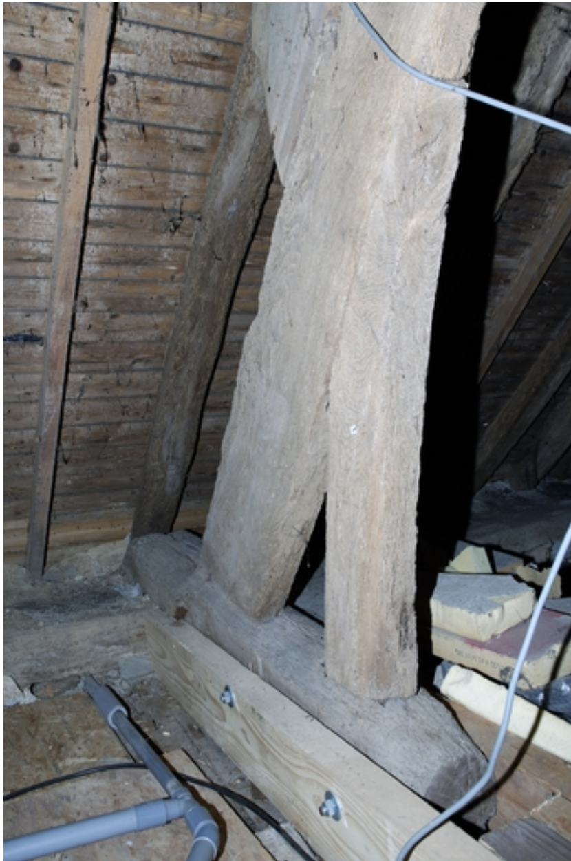
Charpente. Détail de l'entrait scié de la deuxième ferme.
