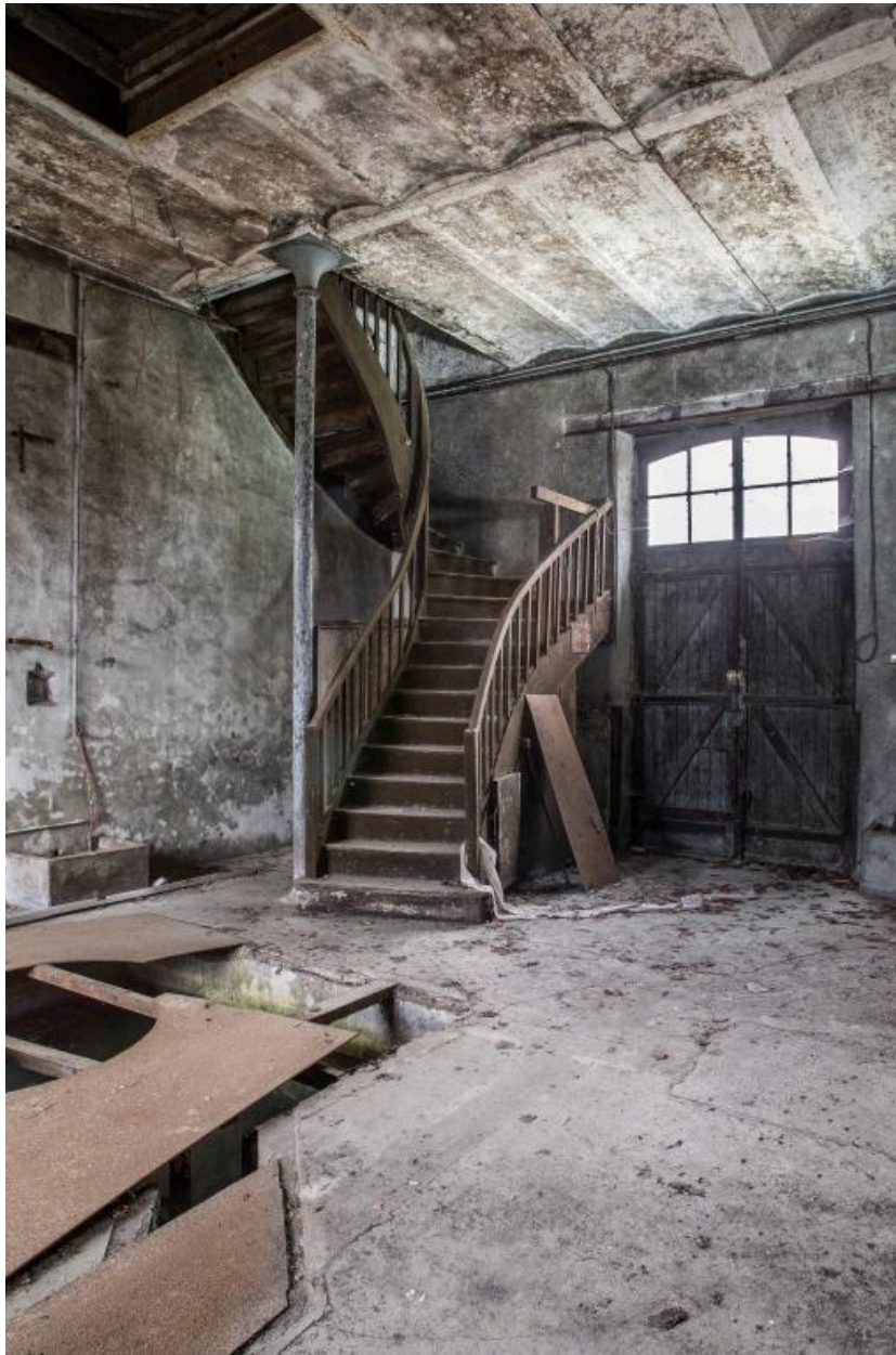
Chai sud, vue intérieure du pavillon : emplacement de l'ancienne colonne à distiller, escalier et porte d'origine, 2018.
