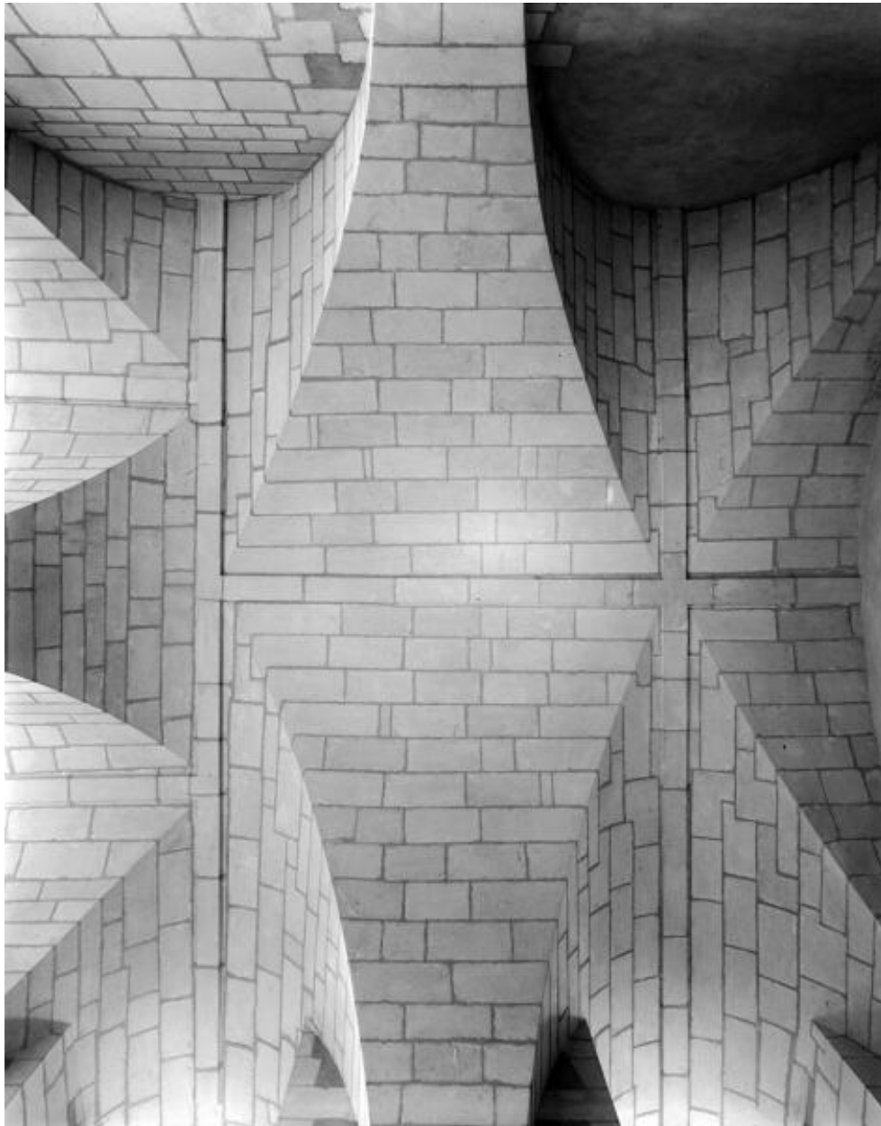
Pavillon sud-est de l'abbaye, bureau du prieur : la voûte.
