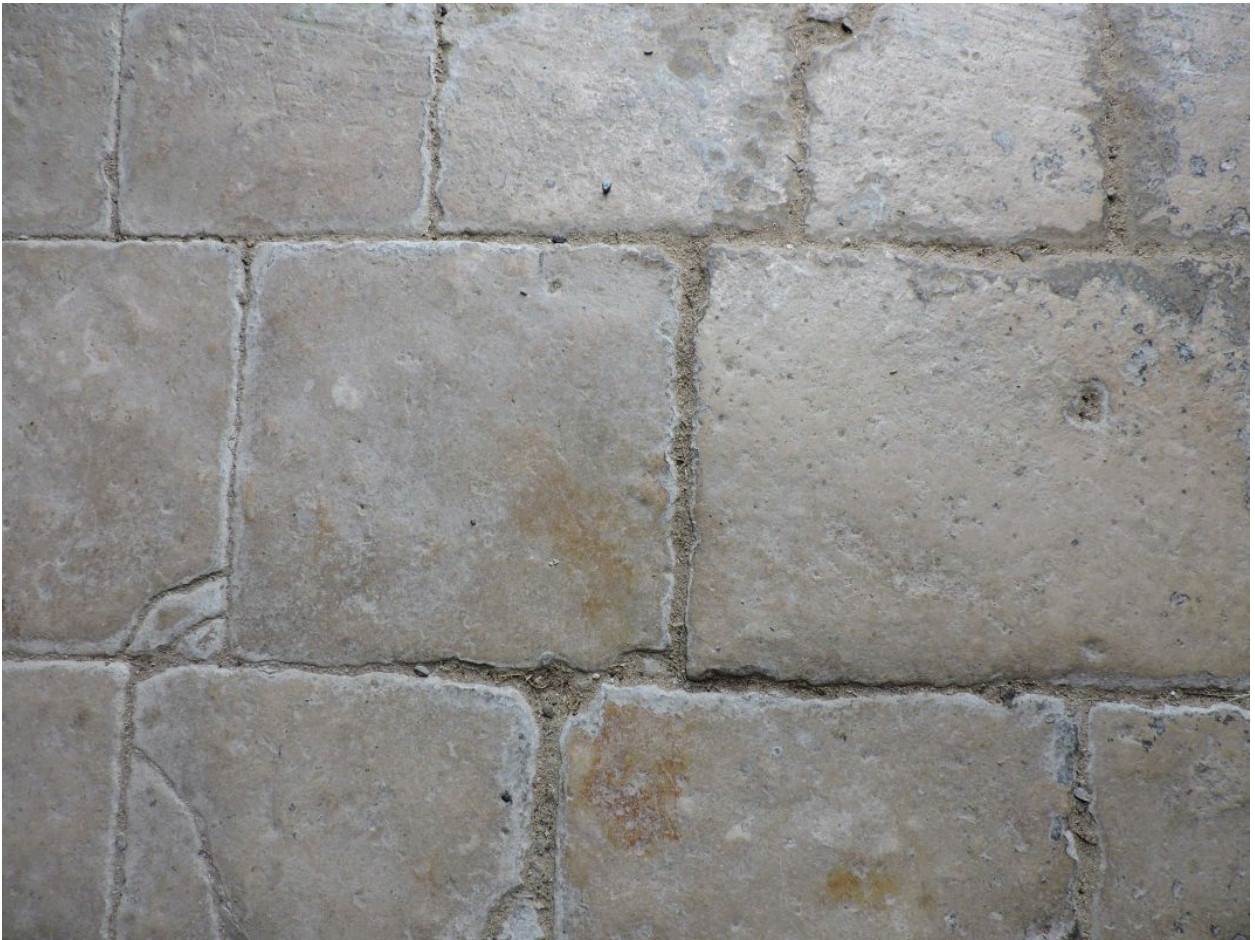
Détail du pavement en pierre de taille de l'ancien logement.
