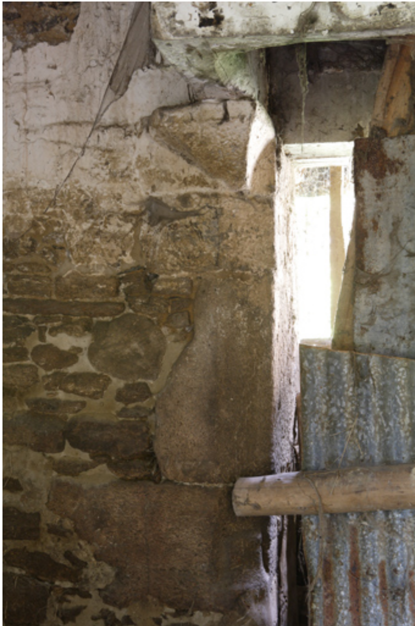
Bâtiment est. Métairie (?). Détail de la console de gauche supportant la hotte de la cheminée.
