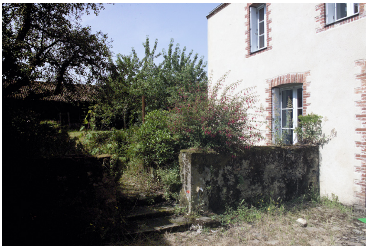
Le corps secondaire de la maison située au centre vue prise de la cour vers le jardin.
