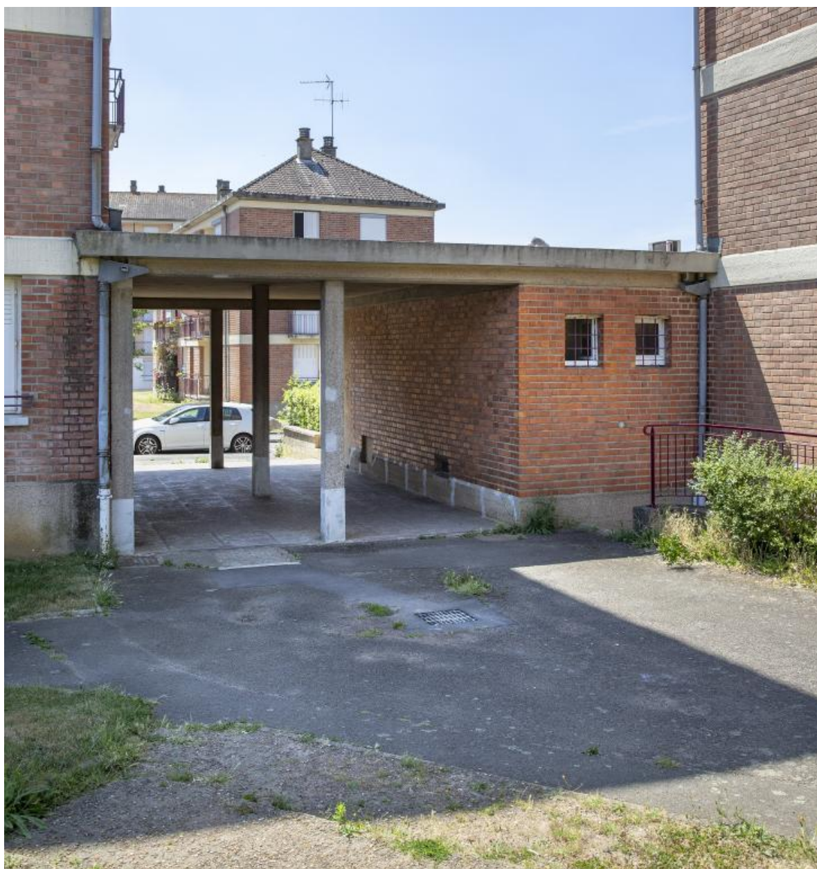
Vue du passage entre les bâtiments A1 et A2 depuis les espaces verts.
