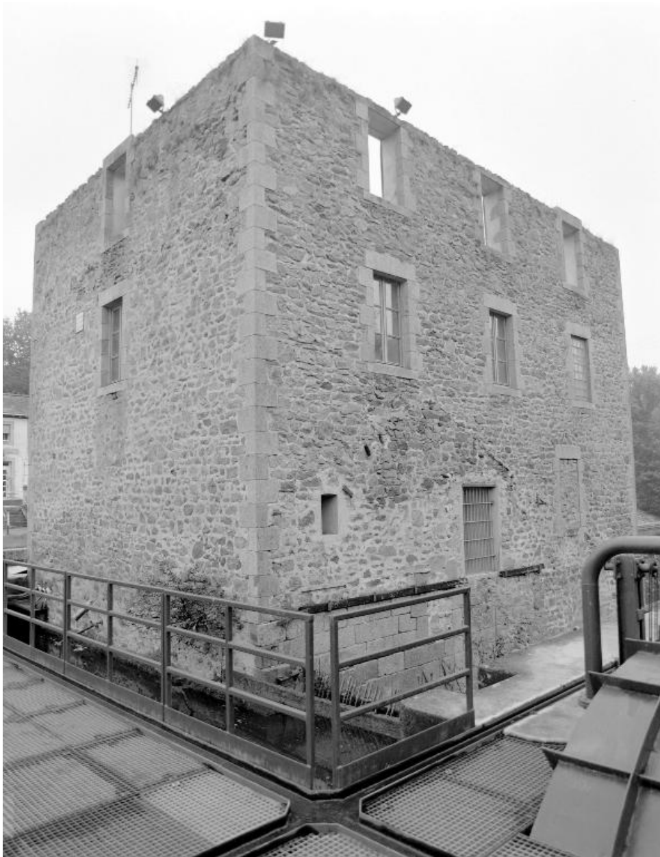
Les façades nord et ouest vues depuis la passerelle d'accès à la micro-centrale électrique.
