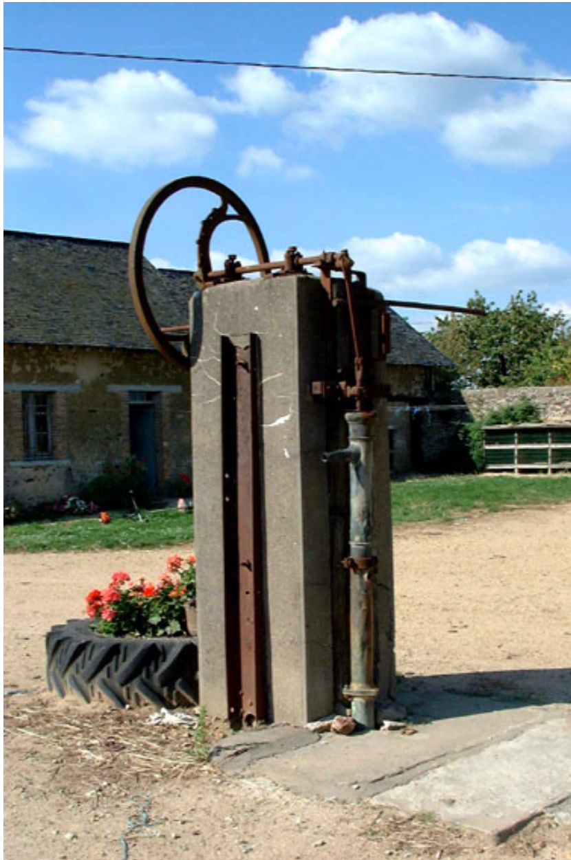
Pompe à eau dans la cour.
