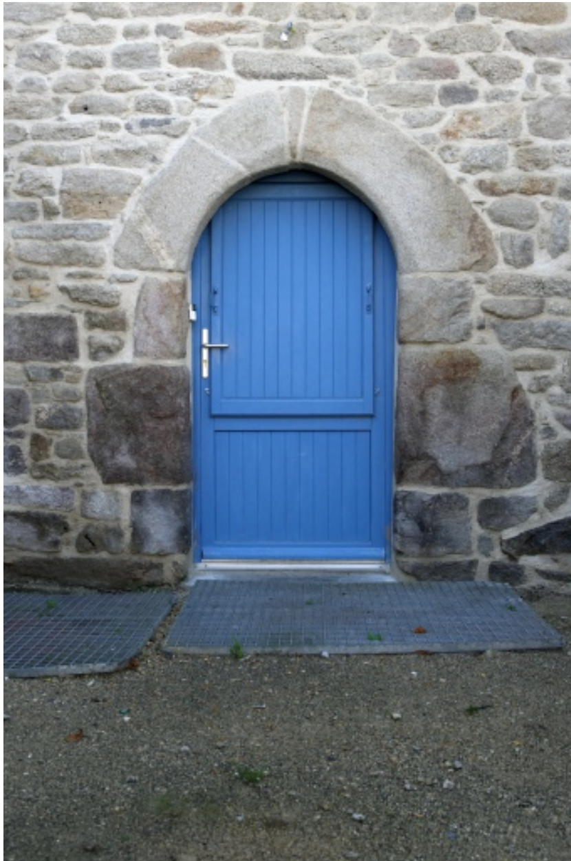
Détail de la porte d'entrée du premier logement (12 rue des Rigadeaux).
