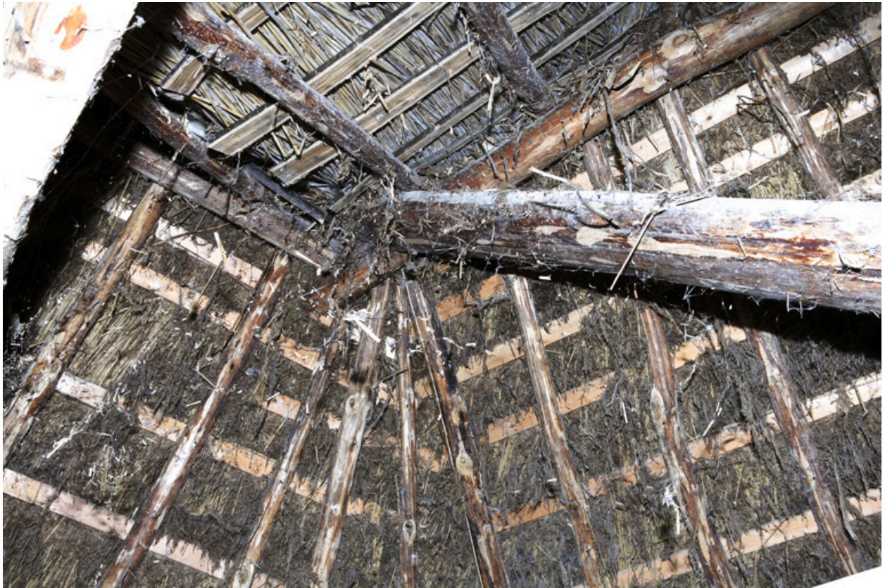
Étable sud. Détail de la charpente au niveau de la croupe.
