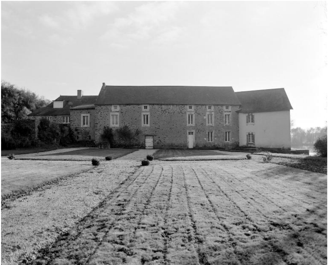
façade nord du logement du meunier et du moulin.
