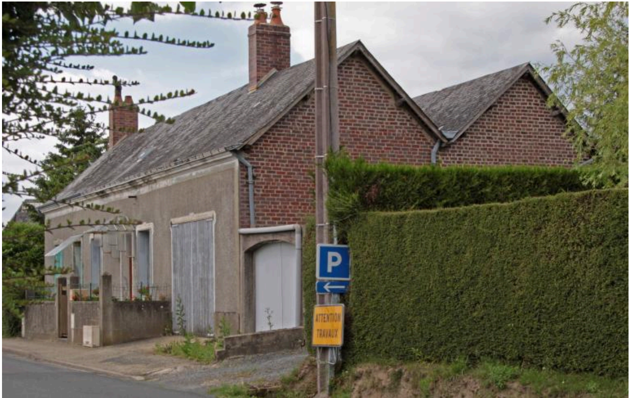
5-7, rue du 19 mars 1962 : vue de volume.
