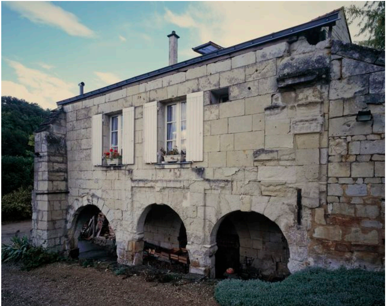
Vue générale de la façade ouest, sur cour, avec galerie de la fin du XVIe ou du début du XVIIe siècle.
