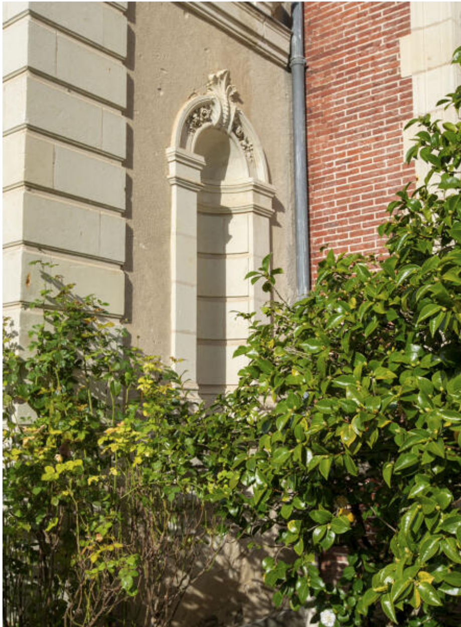
Une niche de l'élévation postérieure.
