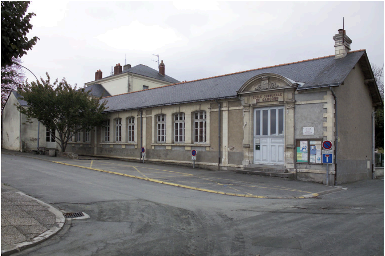
Vue de l'école communale depuis la place (F.Leray, architecte).
