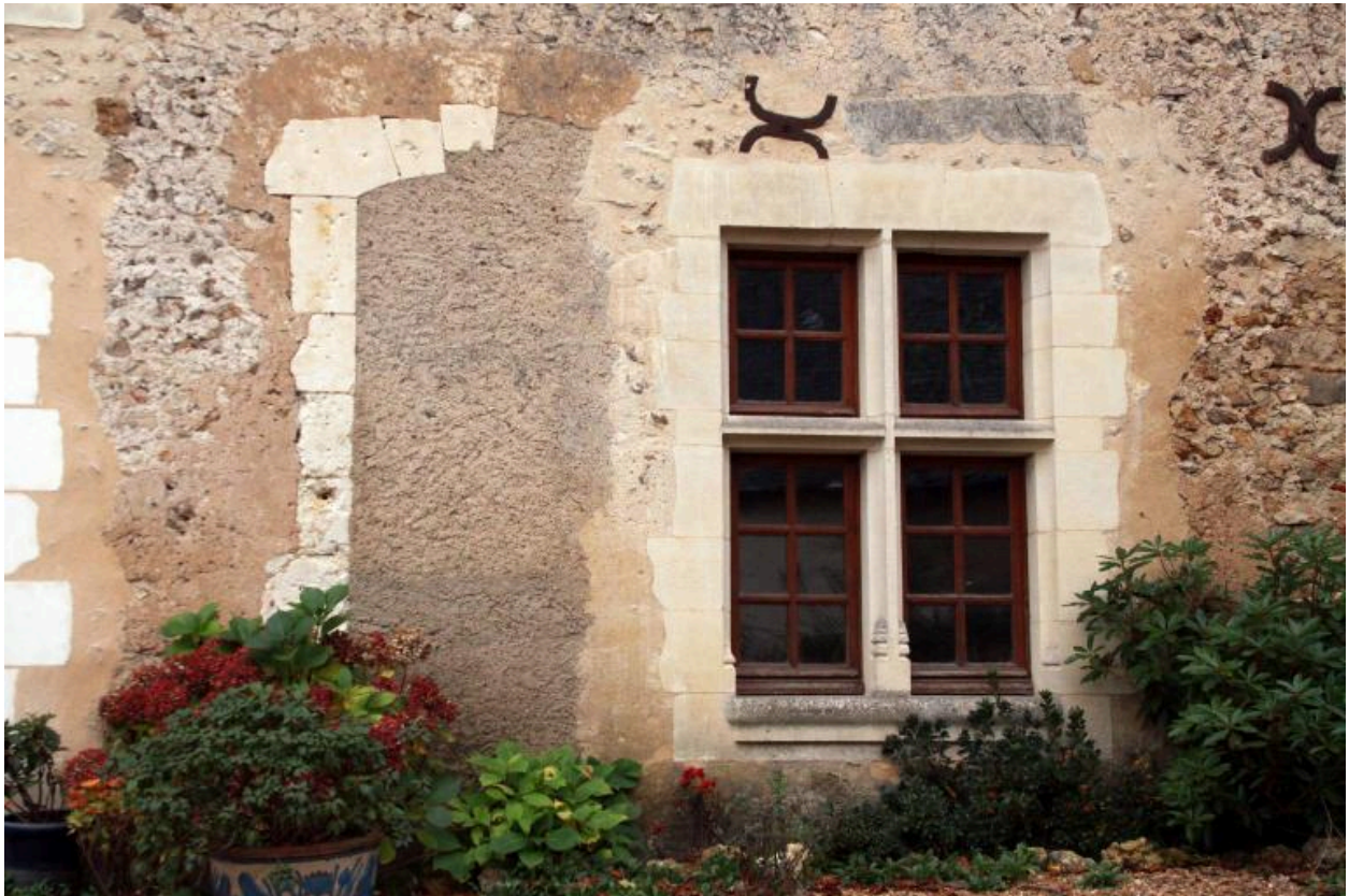
Logis, rez-de-chaussée, baie de la travée droite.
