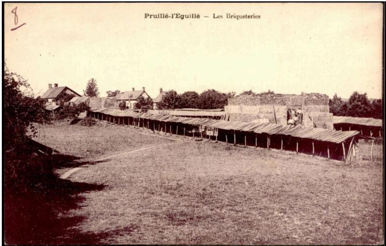
Hangars de séchage des briques, et four à ciel ouvert.
