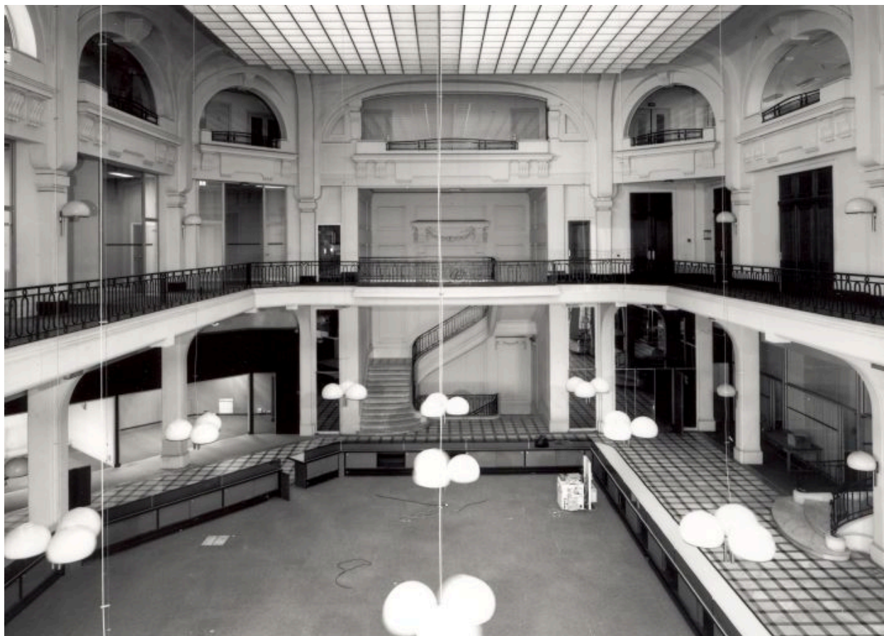
Le hall : élévation latérale droite avec l'escalier d'honneur.
