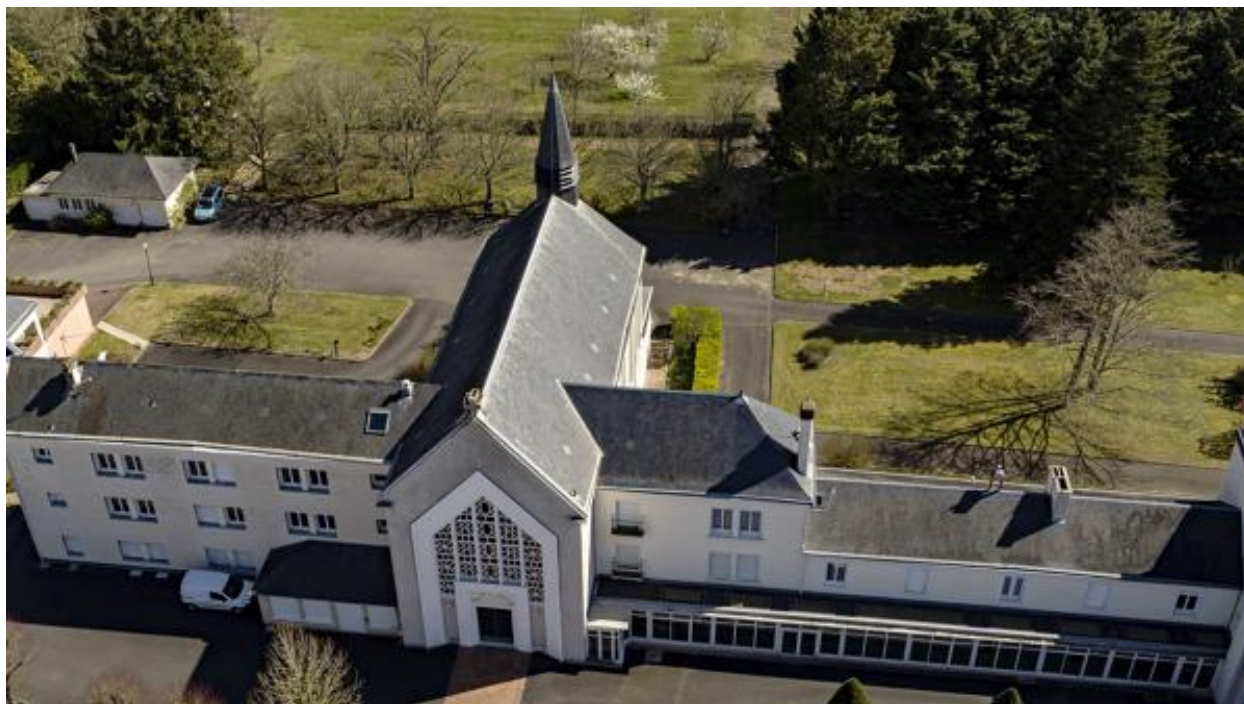
Vue aérienne de la chapelle.
